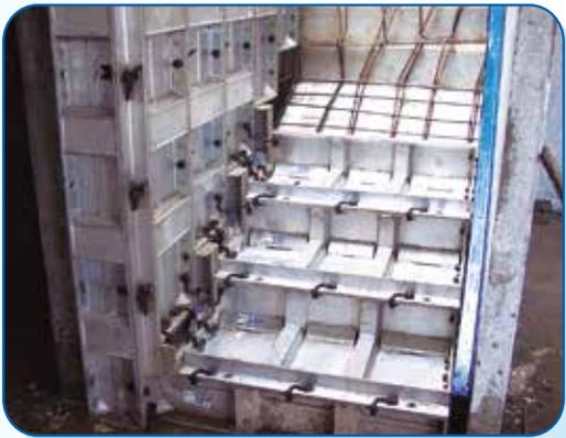
Escadas integradas na laje em paredes de alvenaria
