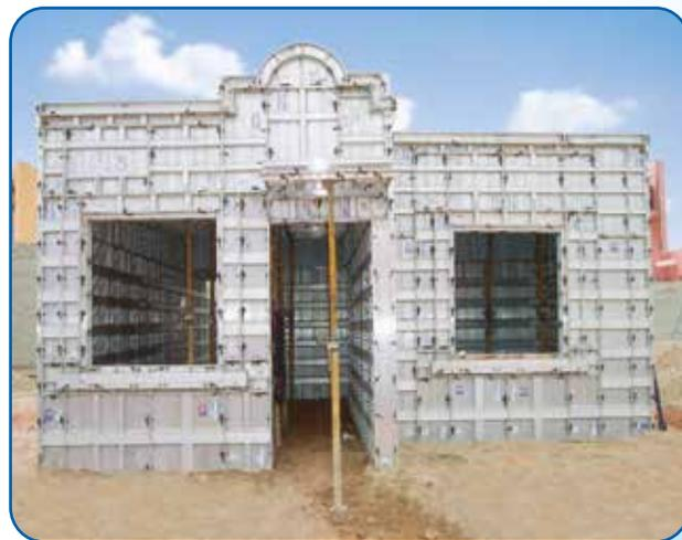
Com os sistemas de alumínio **FORSA** é possível construir frontões curvos, retos ou em diferentes configurações. Negativos de aço, circulares ou retos, são fixados nas formas da parede da fachada como detalhes para posterior instalação de elementos pré-fabricados como gárgulas.
