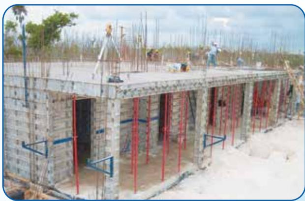
A **FORSA** fabrica painéis de transição de alumínio, que recebem todas as peças que compõem as vigas suspensas. Posteriormente, é instalado o sistema de lajes, com todo o seu escoramento.
