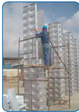
Com as fôrmas dos sistemas de alumínio **FORSA** todos os tipos de seções de pilar (retos, circulares ou elípticas) são alcançados. Esses sistemas são projetados com todo o reforço necessário.
