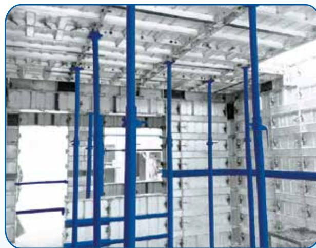
Os acessórios de fixação de painéis em sistemas de parede e laje, são fabricados em aços de alta resistência mecânica com tratamentos térmicos que lhes permitem suportar elevadas cargas de trabalho. As fôrmas de parede podem ser fornecidas com pinos tipo flecha, acessórios fixos e instalados em fôrmas de 45 cm a 60 cm de largura.
